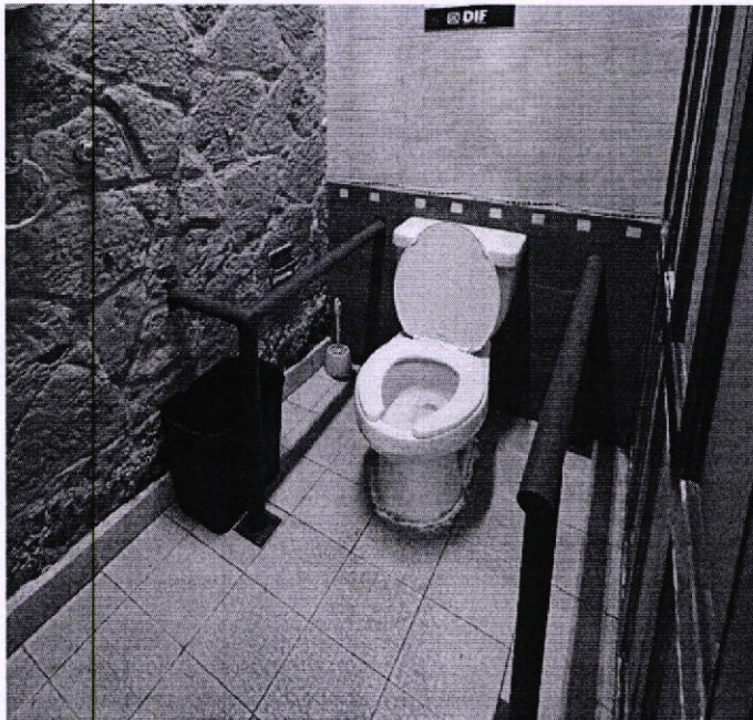
Barandal instalado en sanitario de mujeres
