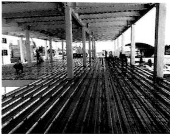
PREPARACION DE LOSA DE ENTREPISO ANTES DE REALIZAR EL VACIADO DE CONCRETO
