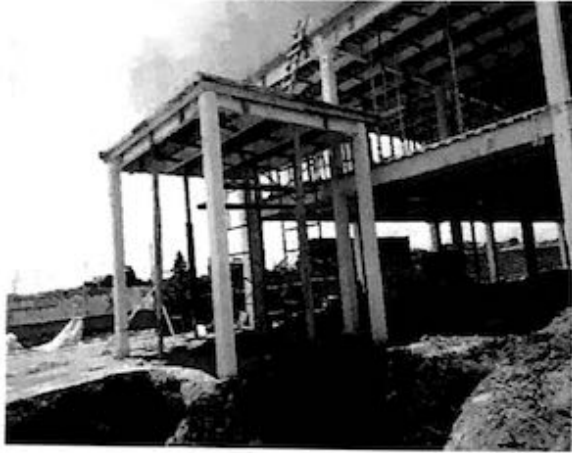
LOSA DE ENTREPISO
